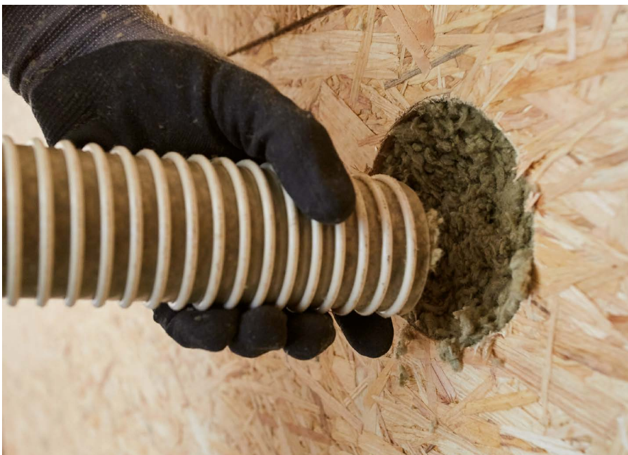
Eine „Fillrock RG Plus“ Einblasdämmung ist als nichtbrennbar A1 klassifiziert und enthält keine Flammschutzmittel oder Borsalze
