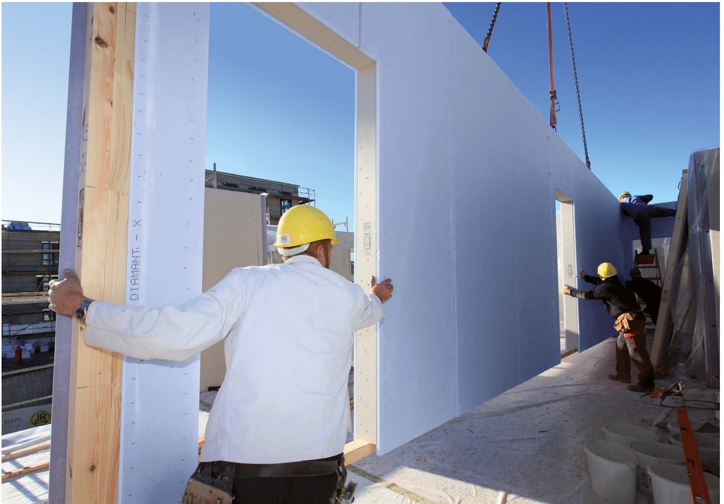
Dank ihrer nachgewiesenen Statik erweitert die geschosshohe Spezialgipsplatte Knauf Diamant X die Möglichkeiten im Holzbau
